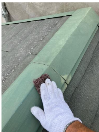
ケレン作業・棟板金
