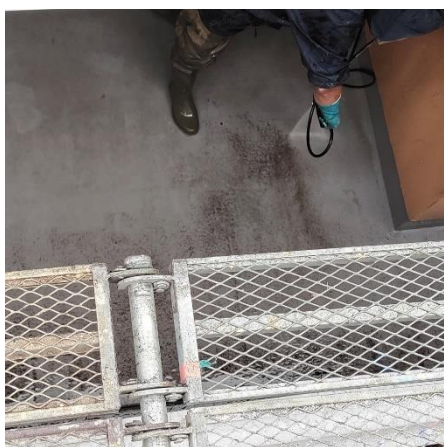
洗浄作業・バルコニー
