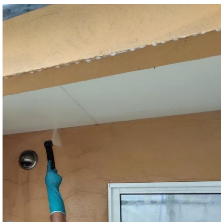
洗浄作業・軒天
