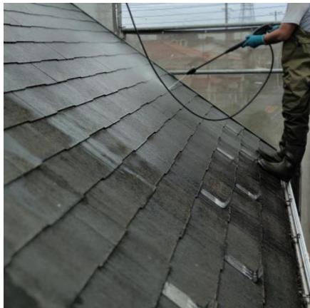
洗浄作業・屋根
