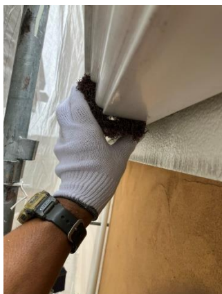
ケレン作業・軒樋
