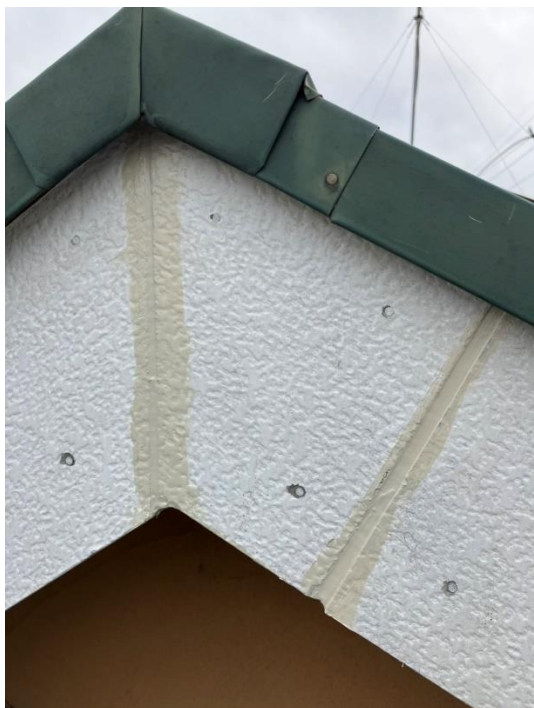
防水シーリング材補修後
