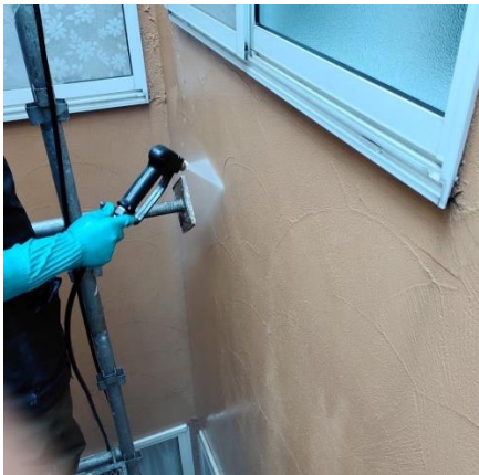
洗浄作業・外壁
