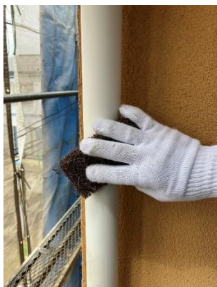
ケレン作業・竪樋
